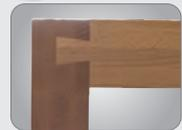
Schwalbenschwanzverzinkung in Hinterzange und Beiladerücken
